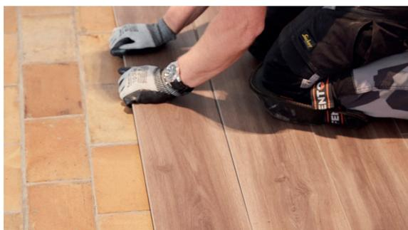
Para instalar la última fila de lamas, normalmente tendrá que cortarlas. Para ello, siga estos pasos: coloque una lama sobre la fila anterior con la ranura orientada hacia la pared. Coloque otra lama boca abajo contra la pared y marque la lama de debajo. Corte la lama siguiendo la marca e instale la última fila.
